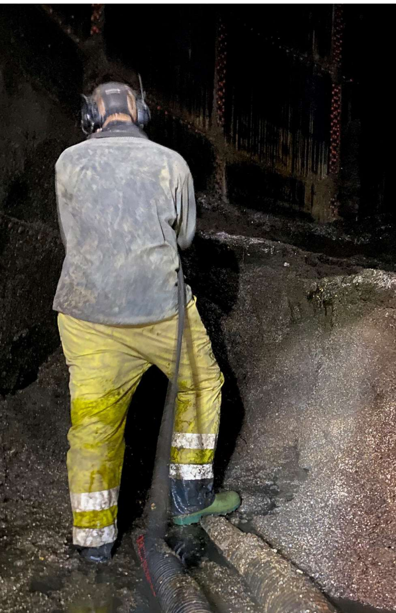
Städning av rötkammare i biogasanläggningen.
